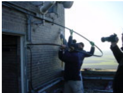
het trekken/duwen van kabels
